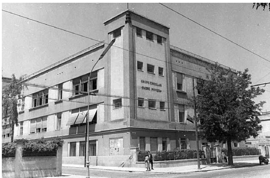
Fotografía 1. Edificio del Grupo Escolar Padre Poveda. Ciudad Jardín (Madrid). FRM ref.495.
