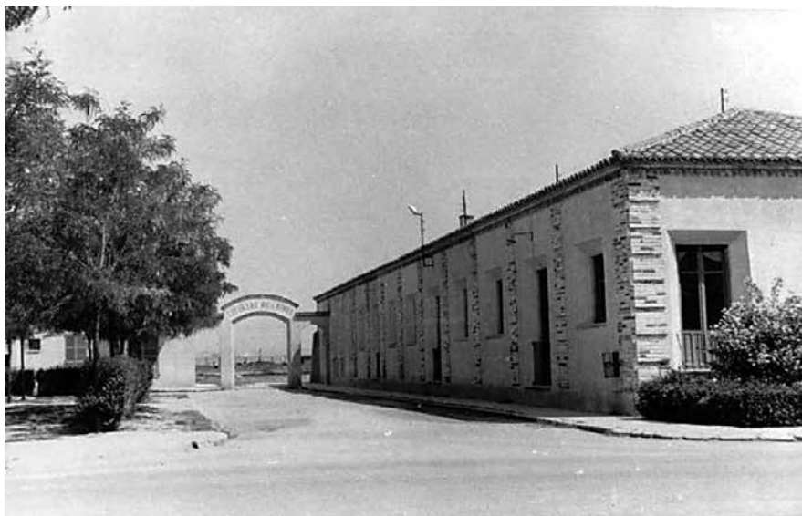
Fotografía 2. Edificio de la Agrupación Escolar Marconi. Villaverde (Madrid). FRM, ref. 338.
